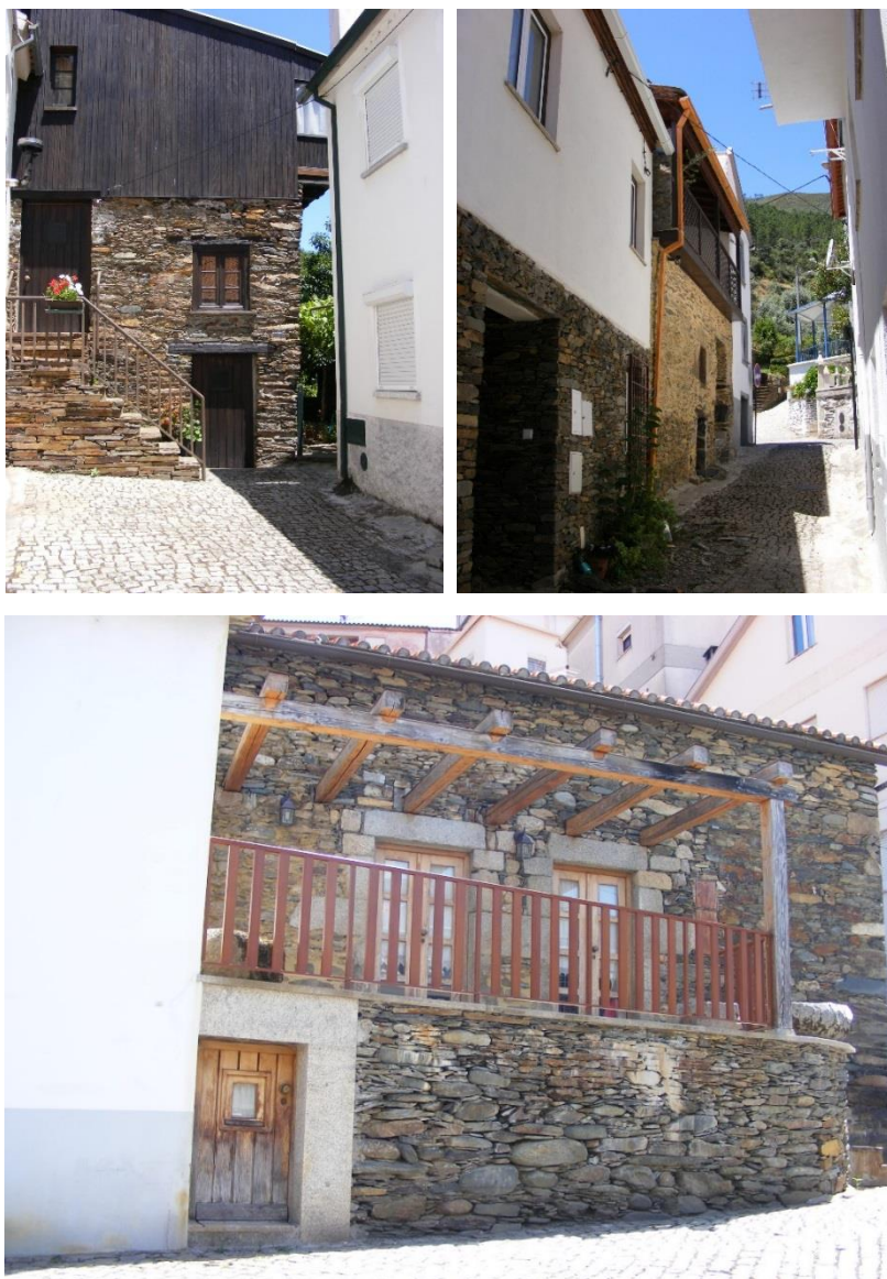
Figura 13: Edifício reabilitado na ARU
