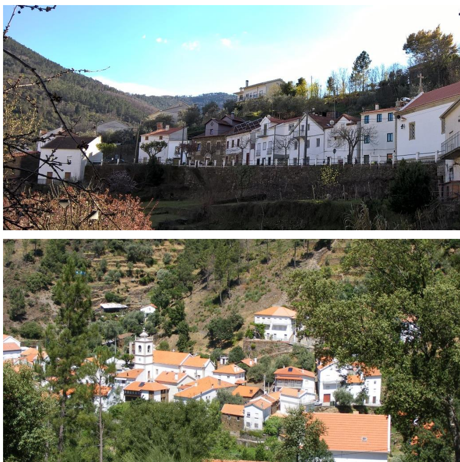
Figura 5: Vistas parciais da margem direita da ribeira do Sameiro
